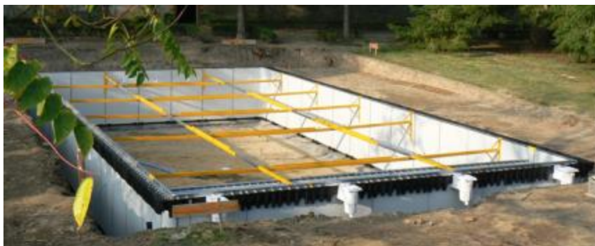
Bassin 14 x 7 m H 1600 mm avec étiayage
