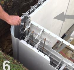
**6**/ FERRAILLAGE DANS LES ANGLES (3 fers Ø 10 mm)
