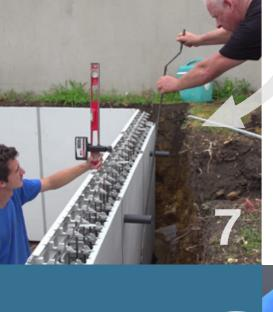
7/ RÉGLAGE DE L'APLOMB DES PANNEAUX À L'AIDE DES VIS INTEGRÉES AUX SABOTS
